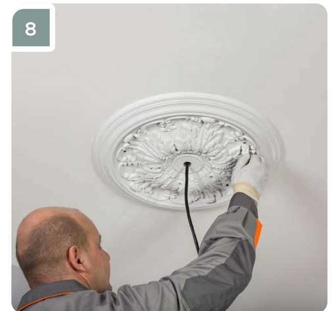
8 Финишной шпаклевкой для внутренних работ зашпаклевать места заглубления саморезов.
