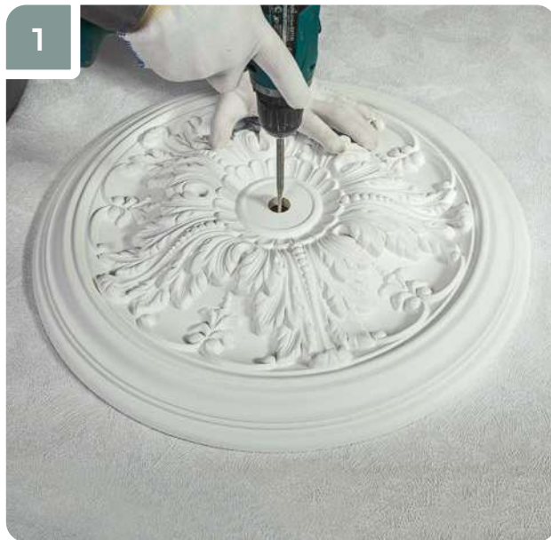
1 Просверлить в изделии отверстие необходимого диаметра.
